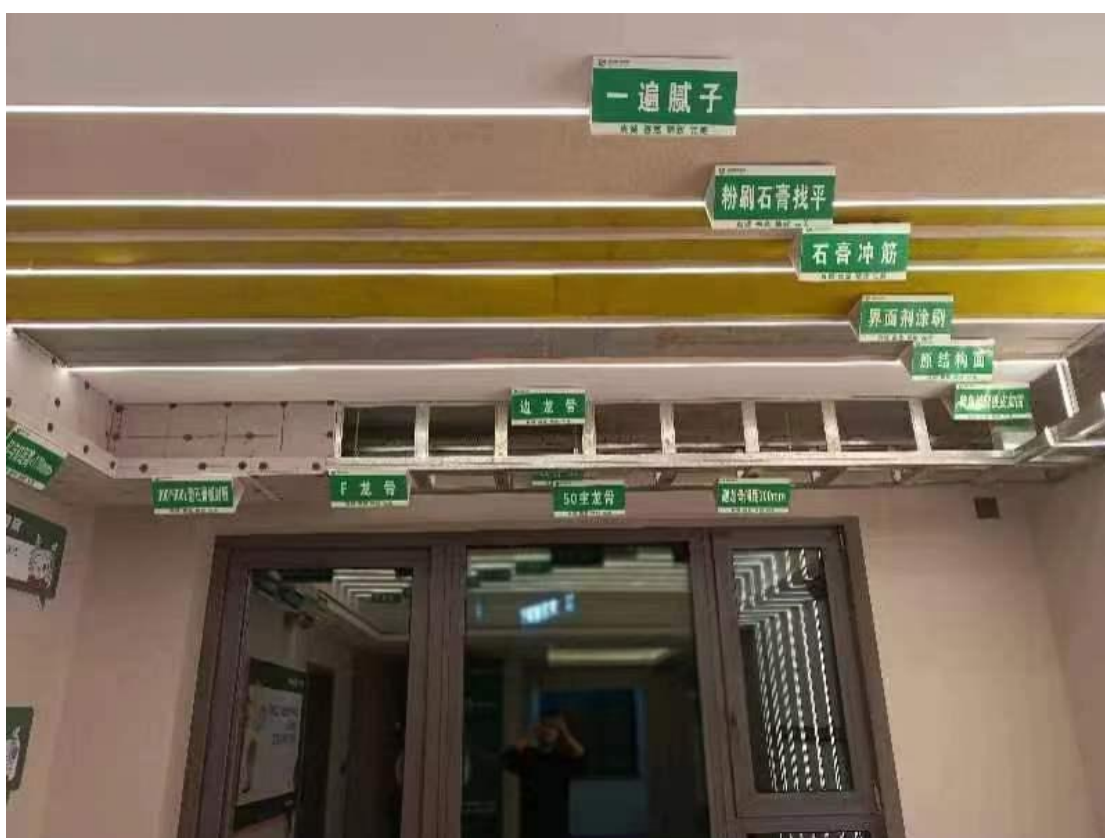
图10 校企共建实训室吊顶工艺展示
